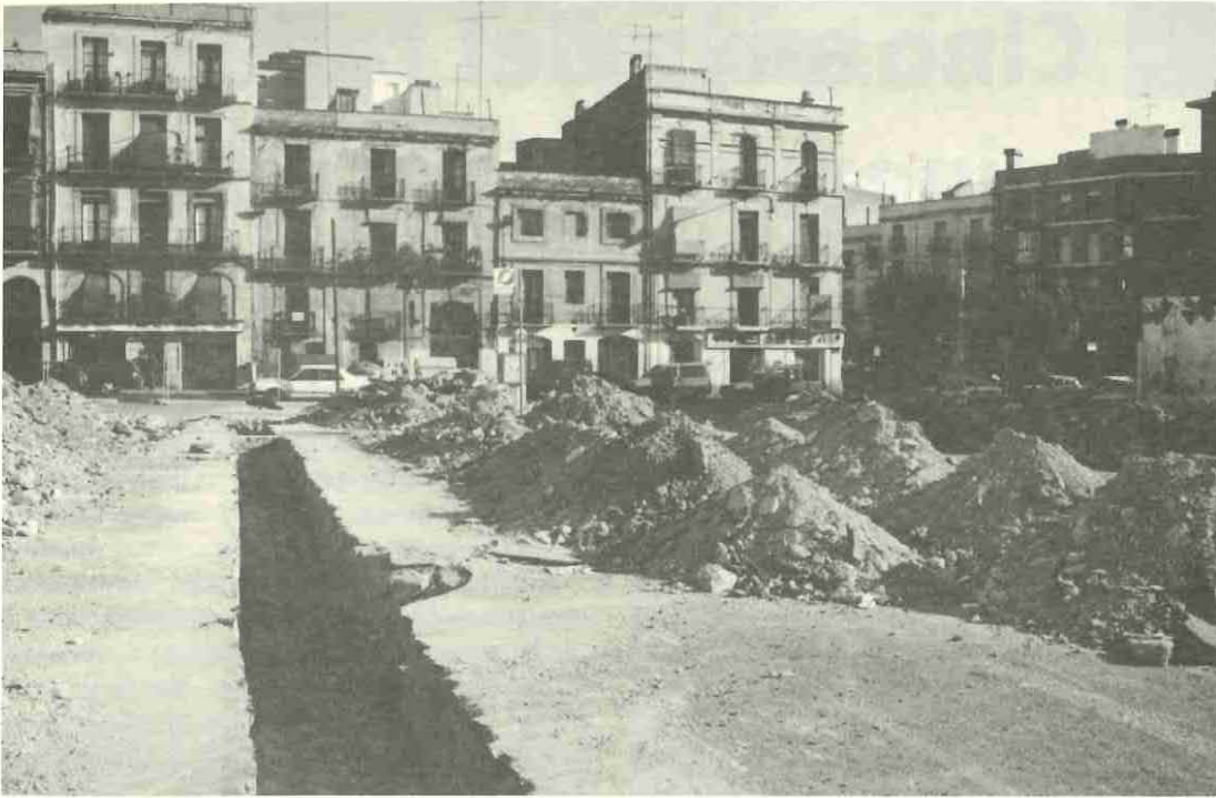
Excavacions a l'aparcament del raval de Palloí
