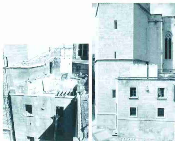
REMEDIACIÓ DE LA CASA DEL CAMPANER.
